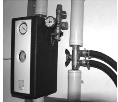
3. Tilslut trykslange (1) og returslange (2) til påfyldningsventil og åbn kugleventilerne. Luk kuglehanen (3).
